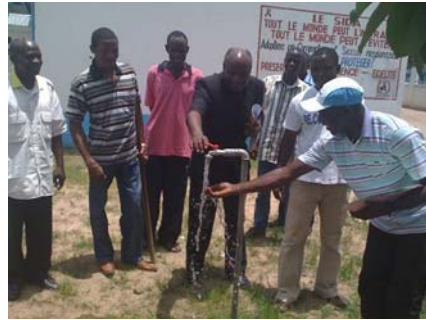
Robinet d'eau installé dans le CSI de Madibou (OMS)
