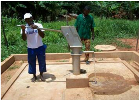
Puits de ferme à Mpassa (UNICEF)
